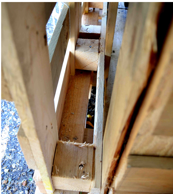
# 3 - Les tenons et mortaises entre palettes verticales et palettes posées au sol pour le plancher
