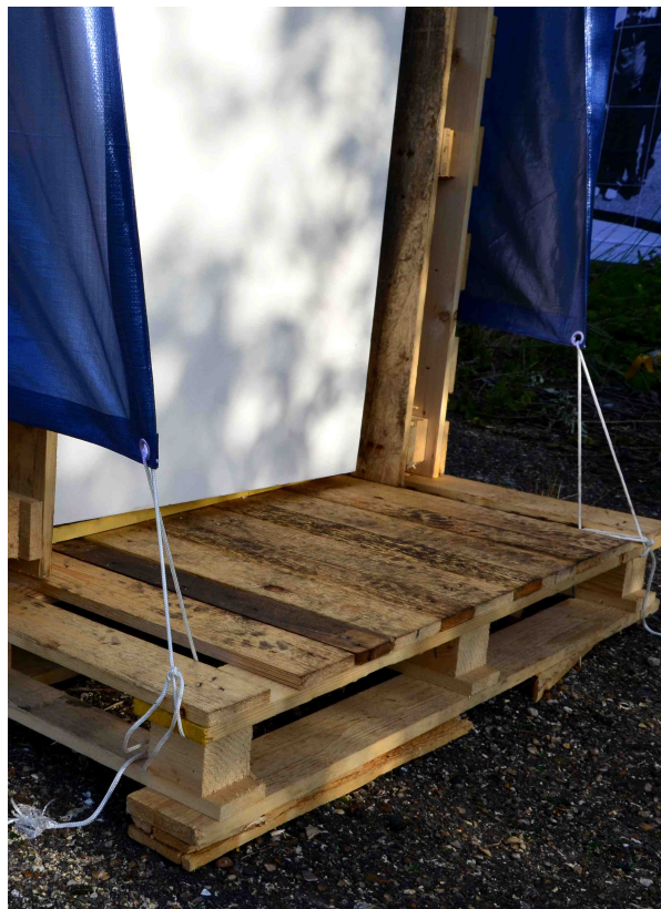
# 7 - Fixer la bâche de toiture aux palettes qui servent de plancher, avec de la drisse
