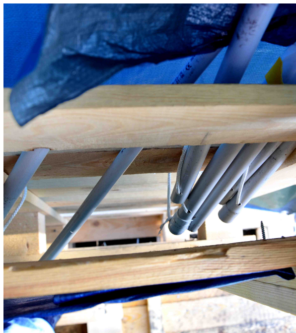
# 6 - Tubes Iro de la charpente fixés aux palettes par des drisses
