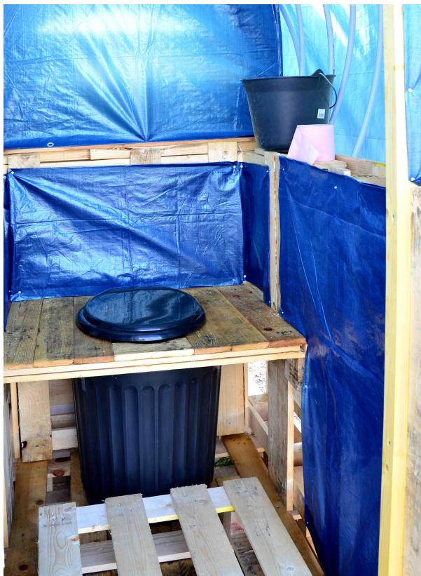
# 9 - 10 et 11 - L'intérieur des toilettes après la pose de l'assise, de la cloison intérieure et des protections basses. (+ une petite marche pour les petits et un sceau rempli de sciure de bois)
